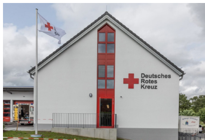
Foto der „frisch sanierten und erweiterten“ Lehrrettungswache in Bitburg.
